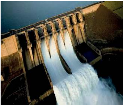
Centrale hydroélectrique, Royaume du Maroc
